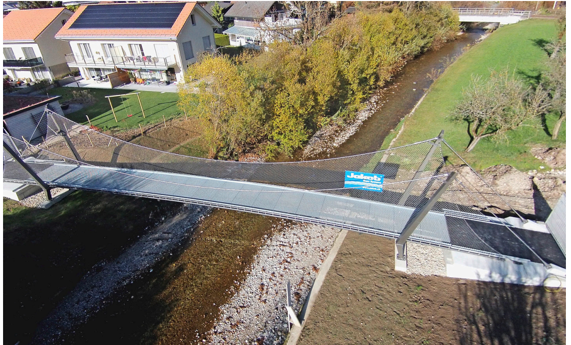
Vorne die neue Hängebrücke, hinten der Bahnübergang mit der angehängten Überführung. Foto: PD
